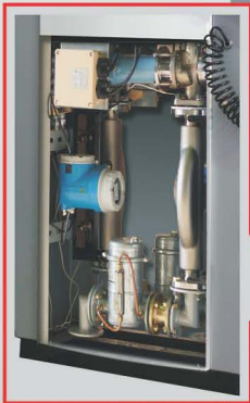
Блок гидравлики с массовым расходомером
